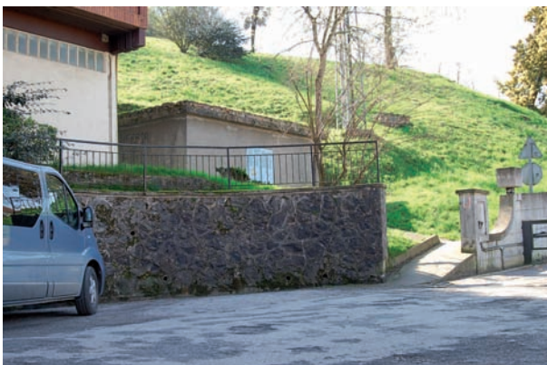
Zona en la que se habilitará una rampa.
