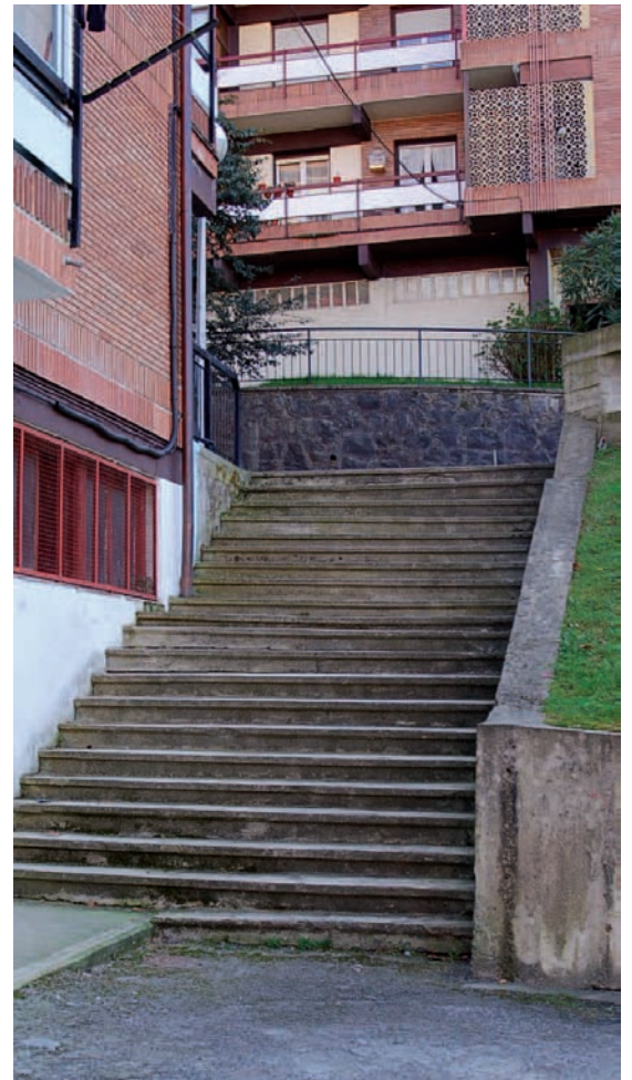
Vista de una de las escaleras que se va a sustituir.
