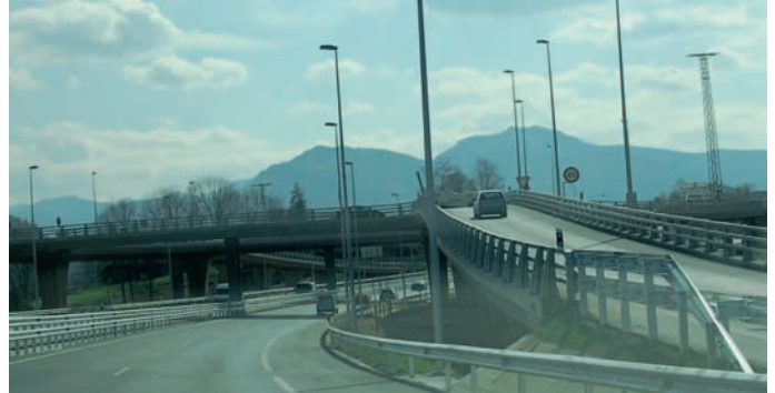
Vista de la nueva infraestructura.
